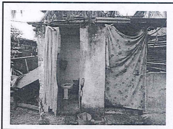
Baño actual de la Vivienda
