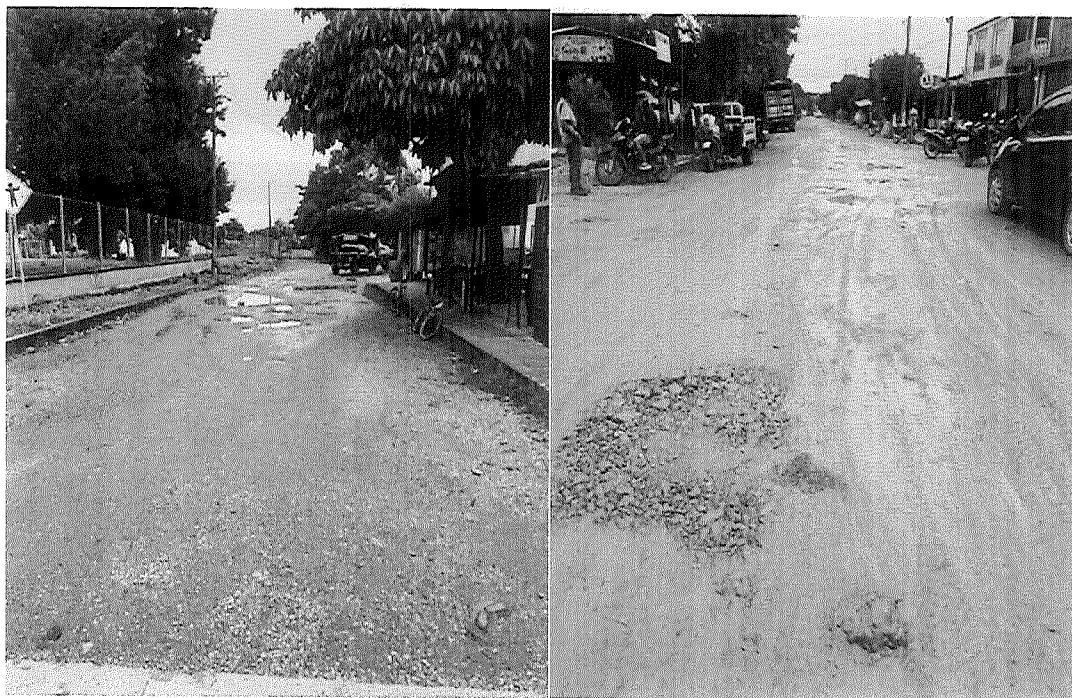
Ilustración 15 estado actual calle 13 entre carrera 18 y 20 Fuente: Archivos del proyecto –Documento Técnico
