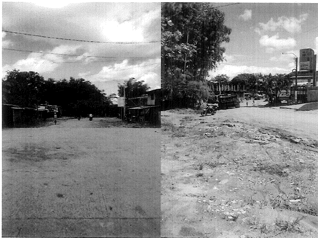
Ilustración 17 estado actual calle 6 entre carrera 8 y 10 – Municipio de Calamar Fuente: Archivos del proyecto –Documento Técnico
