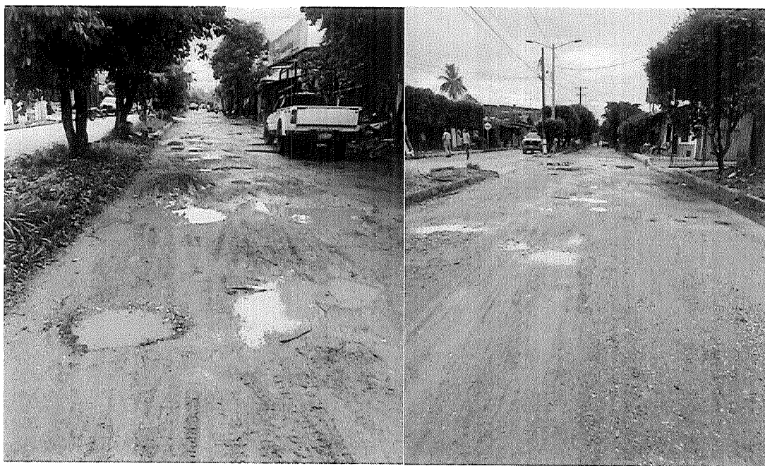
Ilustración 13 estado actual calle 7 entre carrera 18 y 20 Fuente: Archivos del proyecto –Documento Técnico
