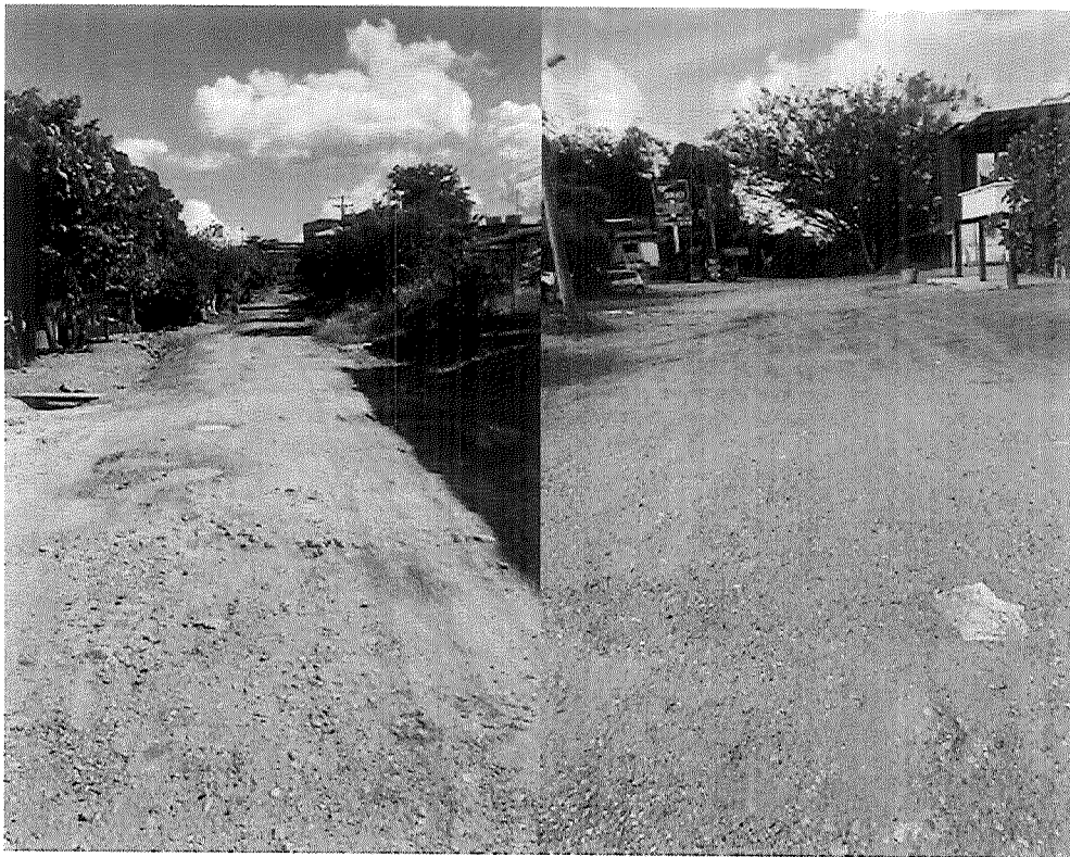
Ilustración 16 estado actual calle 12 entre carrera 4 y 6 -municipio de Retomo Fuente: Archivos del proyecto –Documento Técnico
