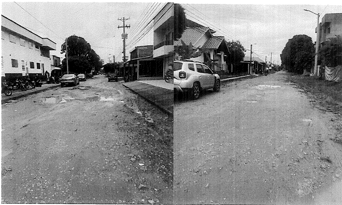
Ilustración 14 estado actual calle 19 entre carrera 20 y 28 Fuente: Archivos del proyecto –Documento Técnico
